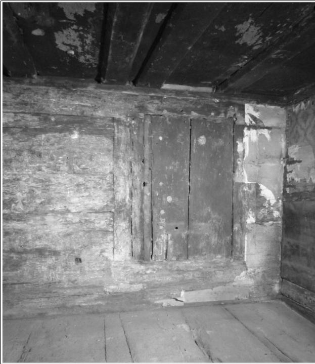
*Fassadensichtig verlegte Bohlen-Balken-Decke, Zimmertüre mit hoher Schwelle und niedriger Türöffnung im spätmittelalterlichen Blockbau aus dem Jahre 1310. Schwyz, Gütschweg 11/13.*
